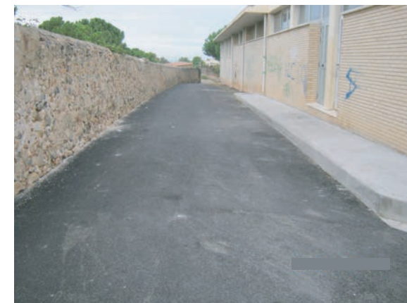
Pavimentació d'un tram del camí de la mina.
