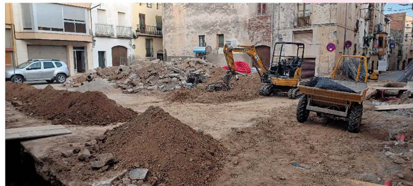
Obres de remodelació de la Placeta.
