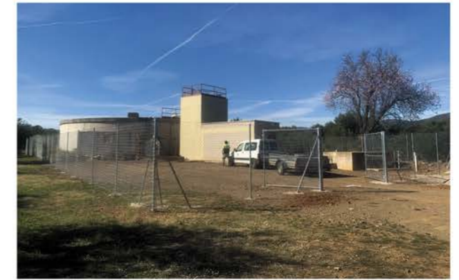
Tancament perimetral del dipòsit del CAT
